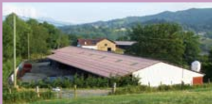
Vue d'ensemble des bâtiments
