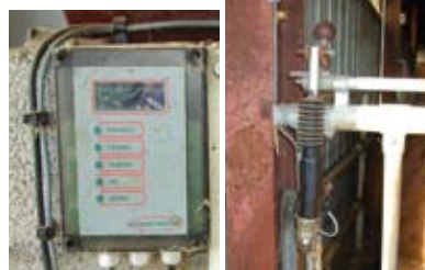
Déverrouillage des cornadis à distance (GAEC CALAS)
